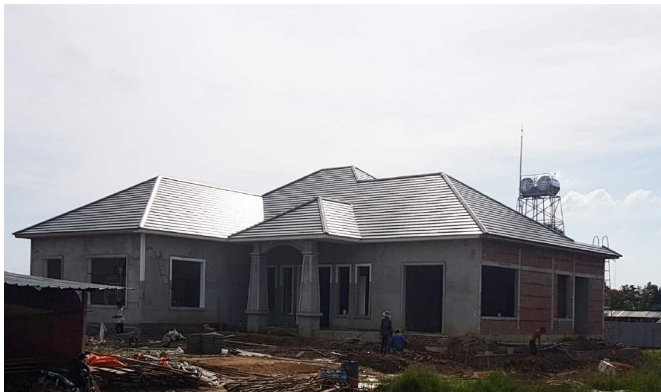
Công trình chi Trúc Củ Chi-Sử dụng ngói P11
